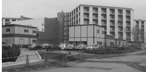
建設中の国際医療センター
